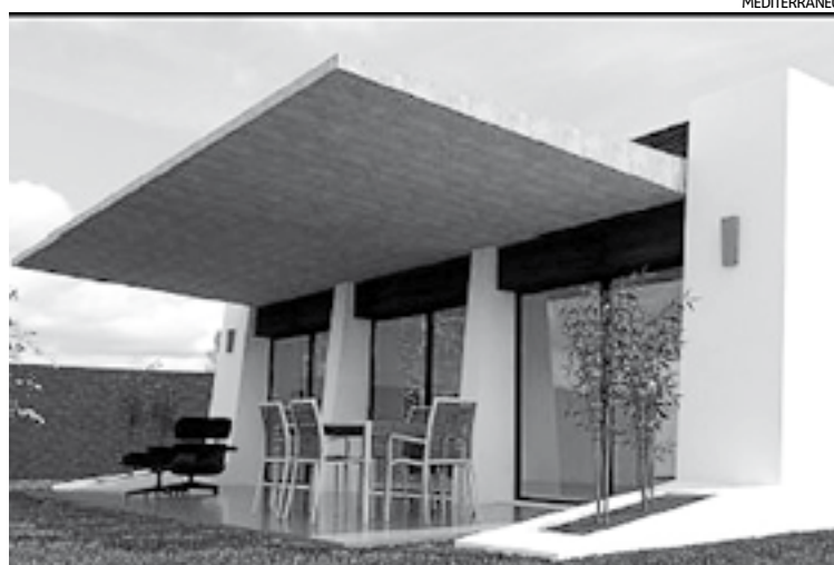
DISEÑO. Uno de los modernos edificios que ofrece Casas de Acero.
